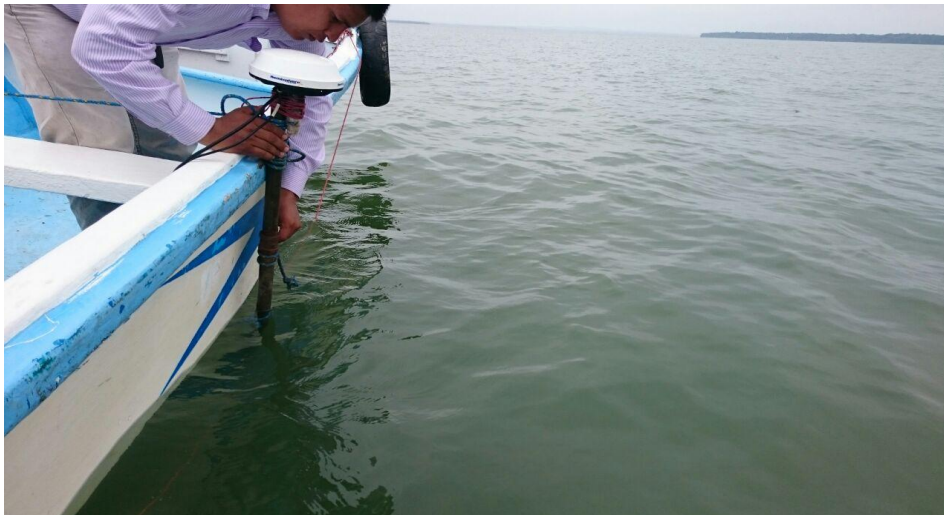
Fotografía 1.18.- Instalación del transducer.
